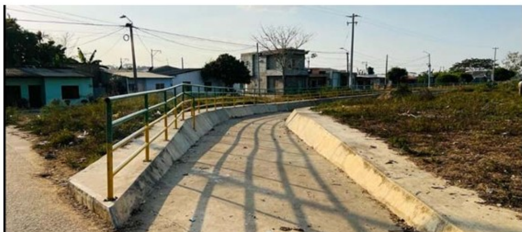
Imagen No.5. Canal colector ubicado entre la calle 6 y el lote y corre paralelo a la Calle 6.
