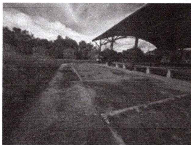
Foto 03: Espacio para baterías sanitarias
