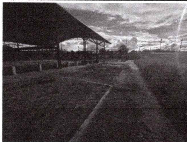
Foto 01: Espacio para baterías sanitarias
