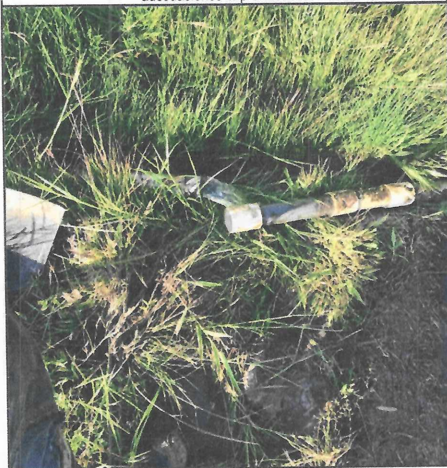
Fotografía No. 5: Tubería en mal estado
