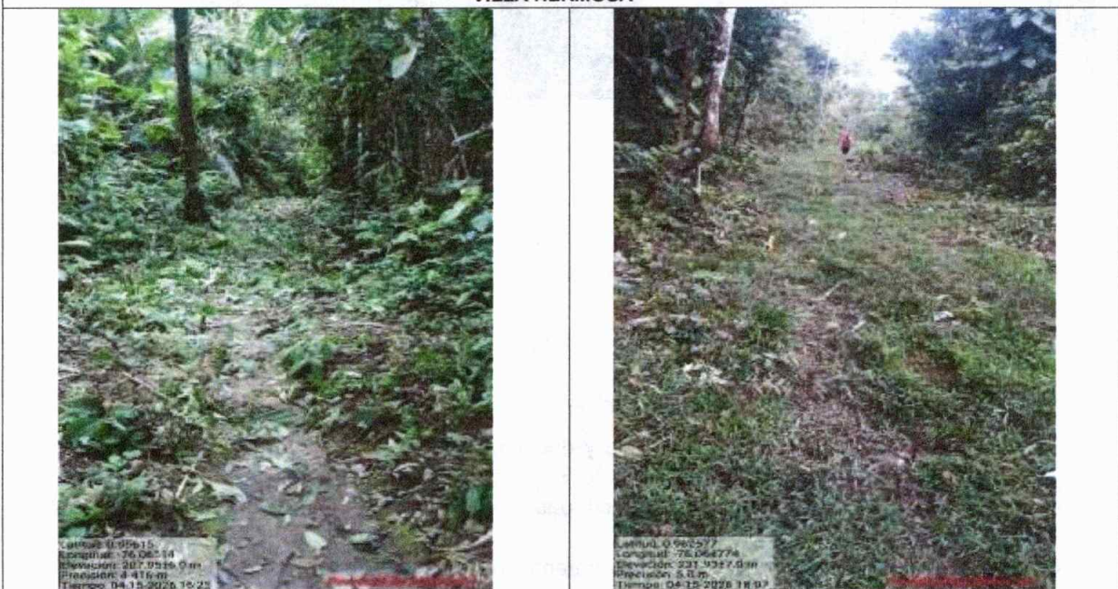
Fotografía No. 07 Condiciones de Intransitabilidad
