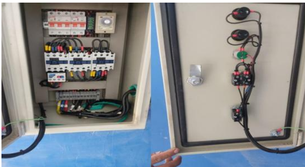
Fotografía 5 Tableros existente - fuente propia.
