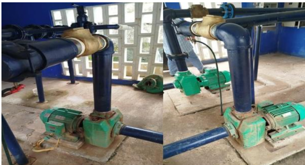
Fotografía 4 sistema de expulsión de agua cruda - Fuente propia
