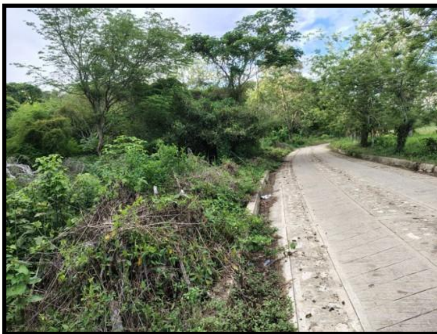
Imagen 16. Zona enmontada en laterales de las vías y cunetas (Barbacoas)
