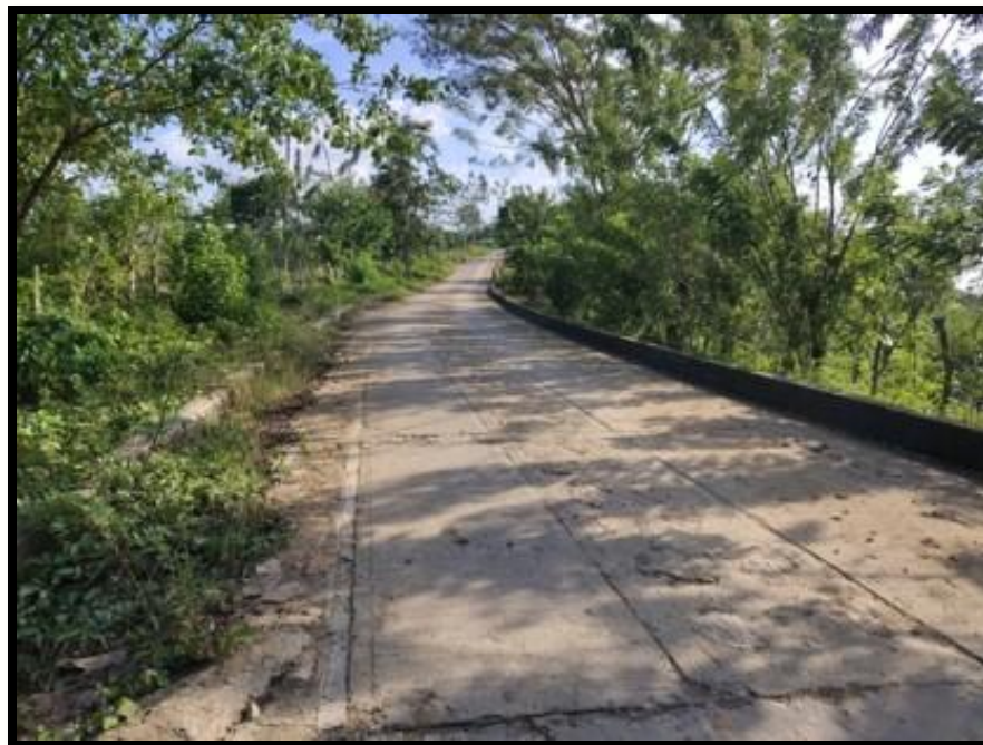
Imagen 13. Zona enmontada en laterales de las vías (Tuchín - San Juan tramo 3)
