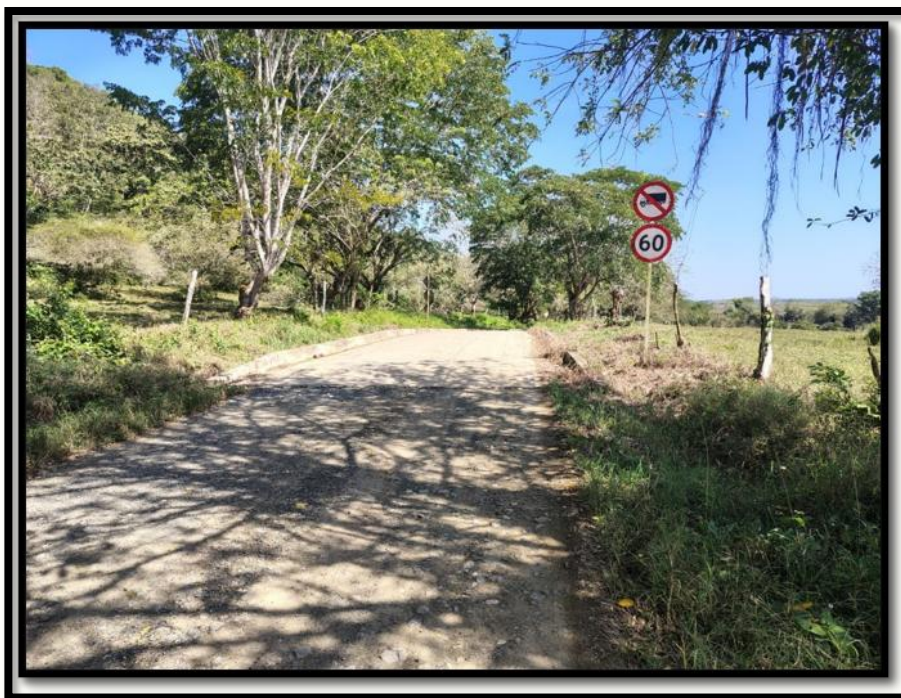
Imagen 2. Zona enmontada en laterales de las vías (Barbacoas - Guaimaral)
