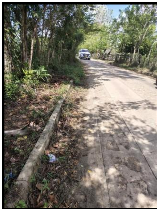
Imagen 28. Cunetas con sedimentos (Las Palomas)
