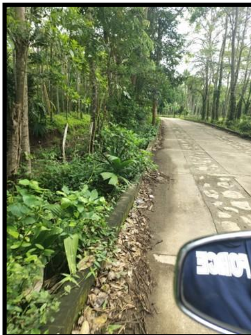
Imagen 7. Cunetas con sedimentos (Tuchín - Nueva Estrella)
