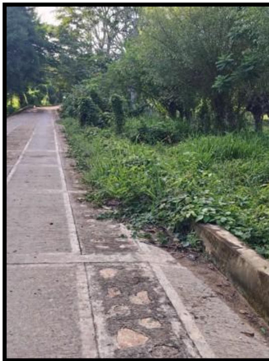
Imagen 5. Zona enmontada en laterales de las vías y cunetas (Barbacoas - Molina tramo 2)
