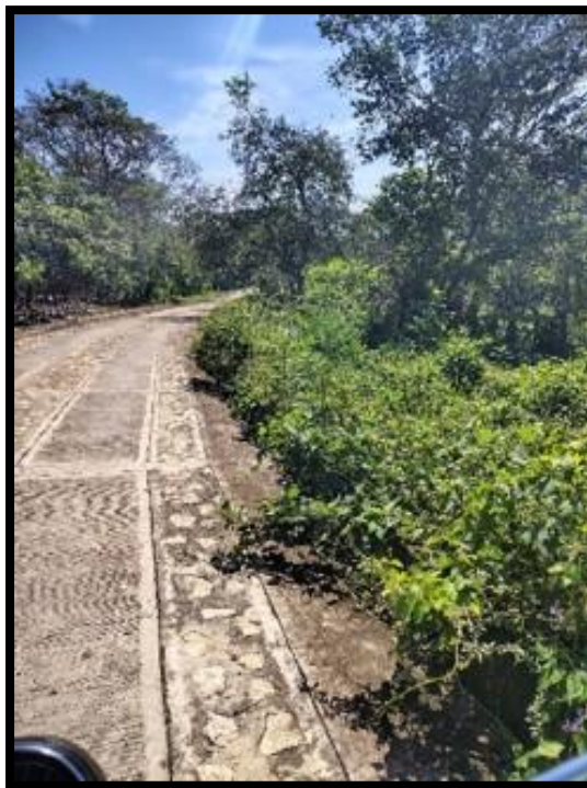
Imagen 3. Zona enmontada en laterales de las vías (Barbacoas - Molina tramo 1)
