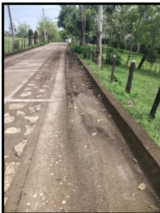
Imagen 7. Cunetas con sedimentos (Tuchín - Nueva Estrella)
