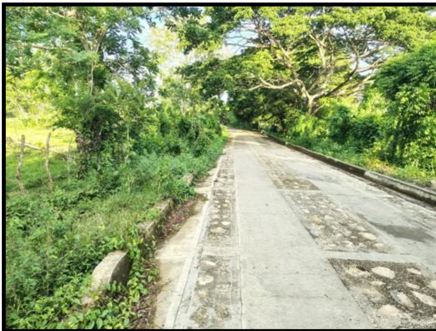
Imagen 6. Zona enmontada en laterales de las vías (Barbacoas - Molina tramo 2)
