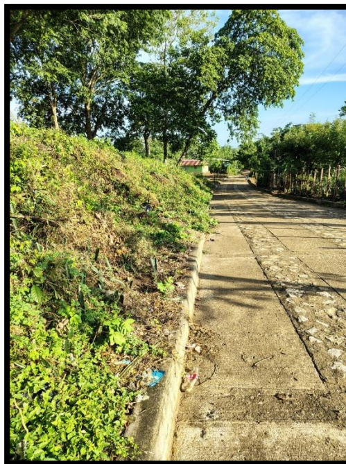
Imagen 17. Zona enmontada en laterales de las vías (Patapelua tramo 1)
