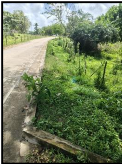
Imagen 31. Zona enmontada en laterales de las vías (Nueva Colombia tramo 2)
