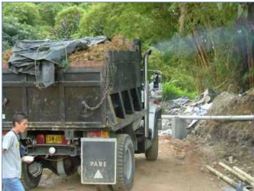
Ilustración 8: Transporte, cargue y descargue de escombros
