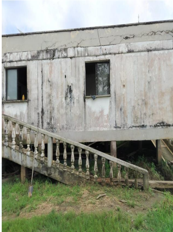
Fotografía 5. Estado actual de la infraestructura de la Estación de Policía.
