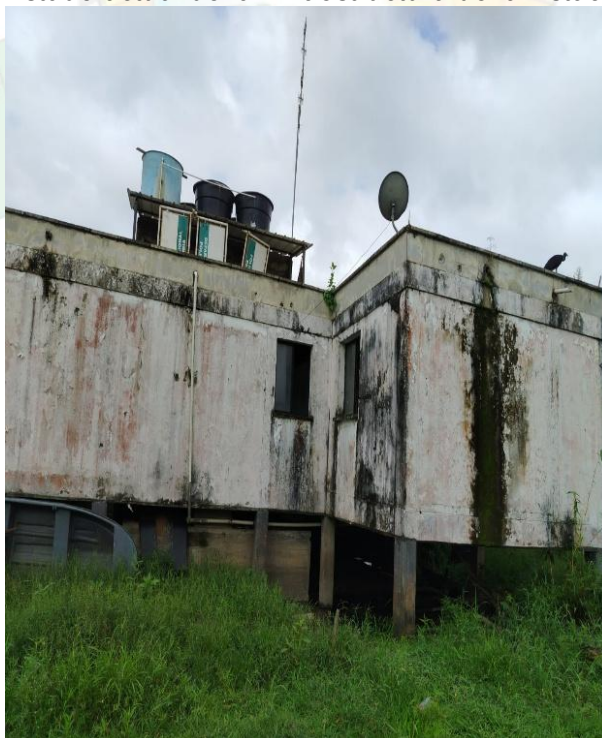
Fotografía 7. Estado actual de la infraestructura de la Estación de Policía.
