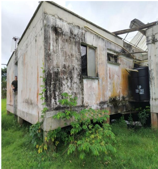
Fotografía 2. Estado actual de la infraestructura de la Estación de Policía.
