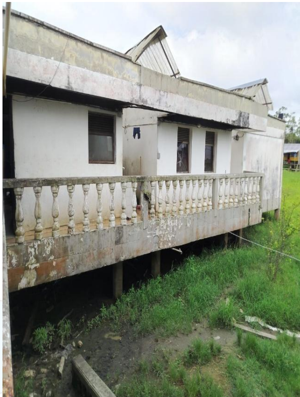
Fotografía 6. Estado actual de la infraestructura de la Estación de Policía.
