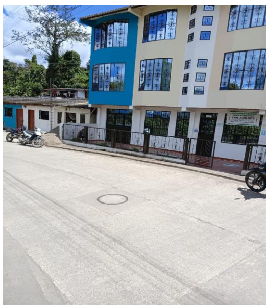
Sede de la ASOCIACIÓN IPS INDIGENA INGA KAMENTSA cercana al desbordamiento de aguas residuales
