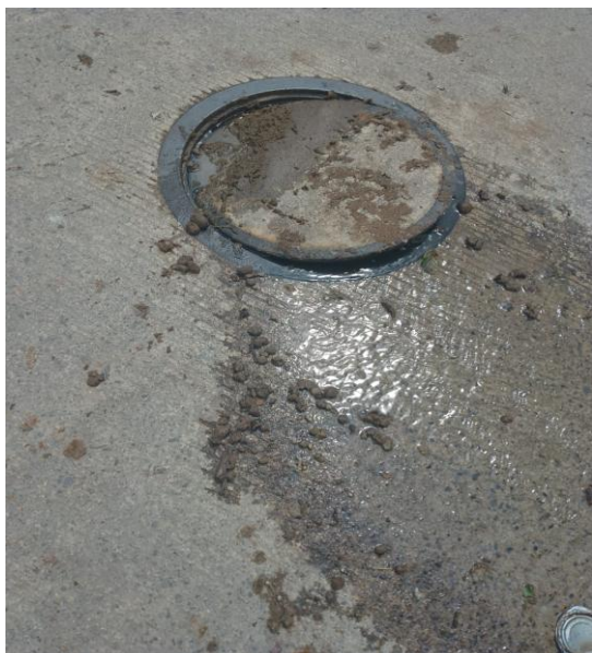
Desbordamiento de las aguas negras por Camaras de inspección.
