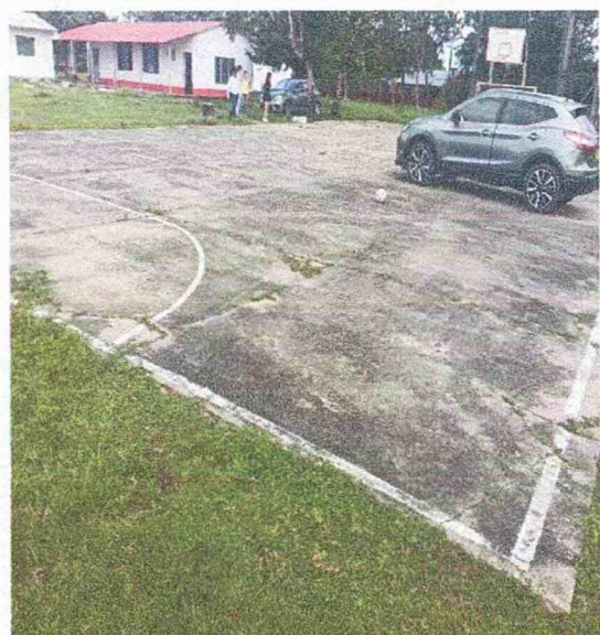
Presencia de fisuras, material vegetal y grietas en placa de concreto
