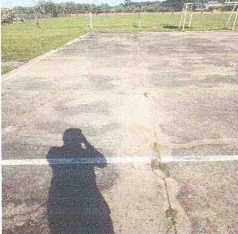
Presencia de fisuras, material vegetal y grietas en placa de concreto
