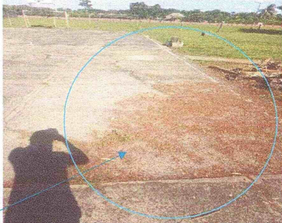
Levantamiento y asentamiento placa
