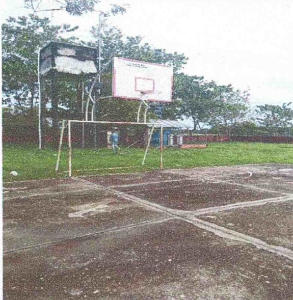
desprendimientos, y exposición de agregados de la placa, crecimiento de material vegetal entre juntas
