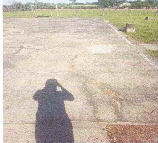
Presencia de fisuras, material vegetal y grietas en placa de concreto
