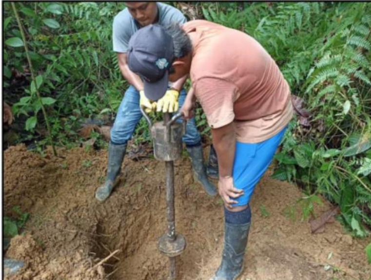
Caracterización Geotécnica Río Guelmambi – Margen Derecha
