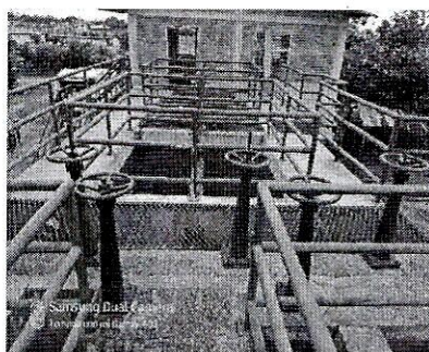
PTAP – Infraestructura existente
