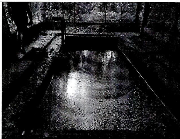
Sistema de tratamiento preliminar - Desarenador
