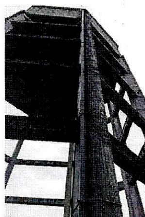
Tanque elevado de almacenamiento PTAP
