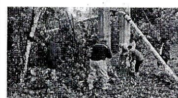
Línea de conducción (viaducto) estructura anterior.
