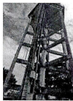
Escaleras de acceso al Tanque elevado de almacenamiento PTAP
