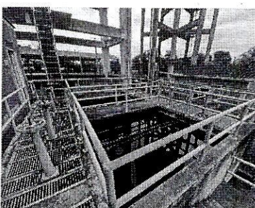
Floculador y sedimentador PTAP
