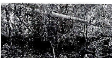
Línea de conducción (viaducto)
