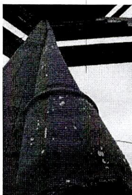
Tubería de salida Tanque elevado de almacenamiento PTAP
