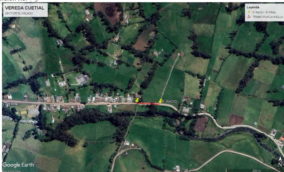
Imagen 1. Estado Actual Tramo Vereda Cuetial Sector El Salado.
