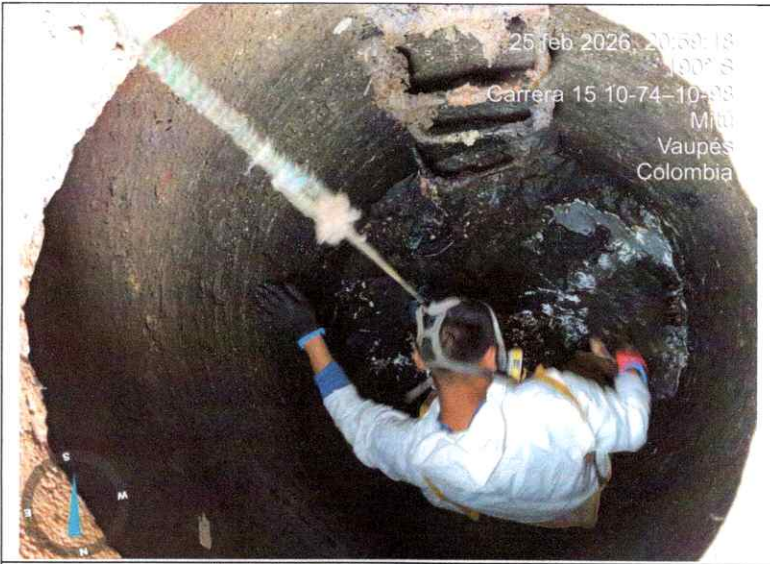
Mantenimiento Redes de Alcantarillado
