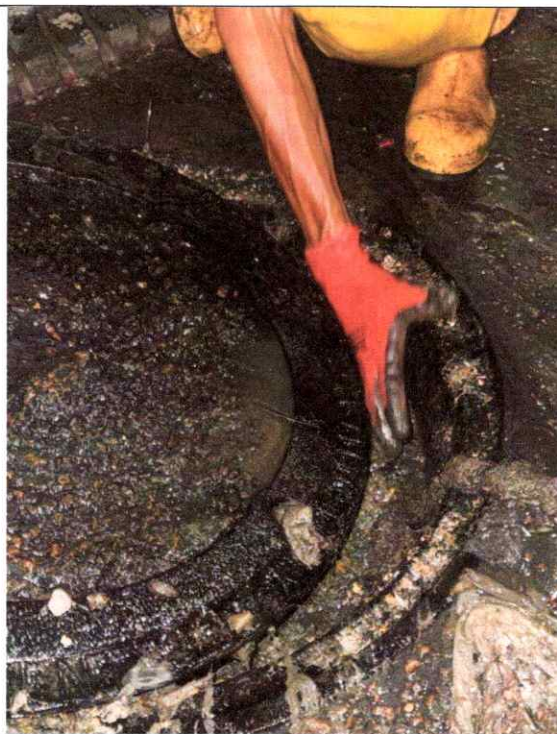
Mantenimiento Redes de Alcantarillado
