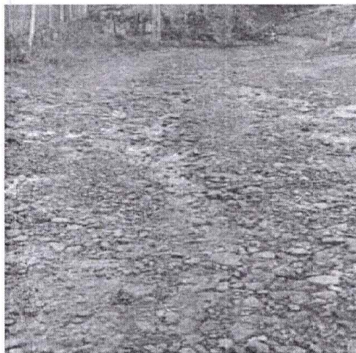
Imagen 13. Localización, registro fotográfico y perfil (mayor al 7%) Placa huella vía Vereda Santa Bárbara– Vereda Santuario, Sector La Escuela, tramo 130 metros lineales
