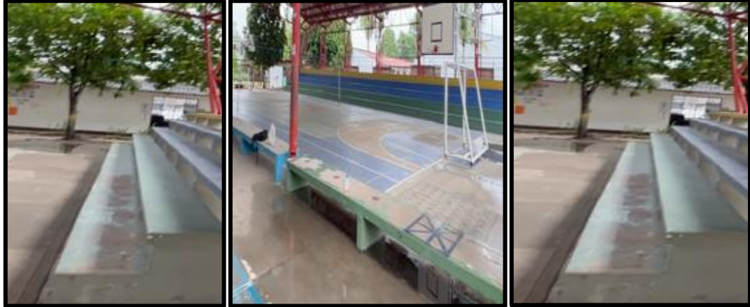
Ilustración 17: Graderías, barandas perimetrales y rejas. I.E. Custodio.
