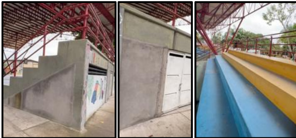
Ilustración 22: Graderías objeto de intervención en I.E. Libertadores.
