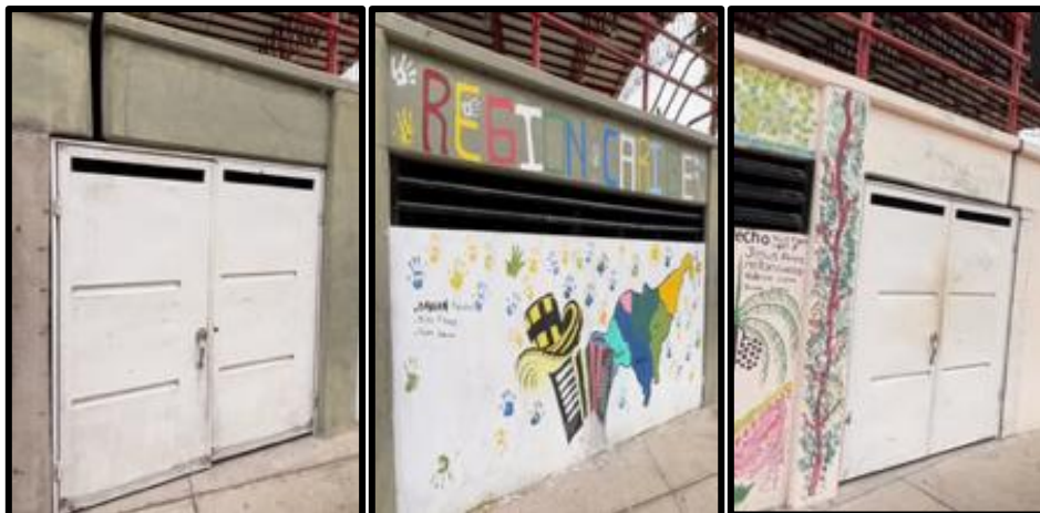
Ilustración 24: Puertas, ventanas objetos del mantenimiento en la I.E. Libertadores.
