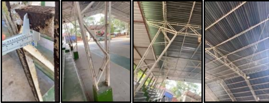
Ilustración 13: Estructura Metálica objeto del cambio de recubrimiento.
