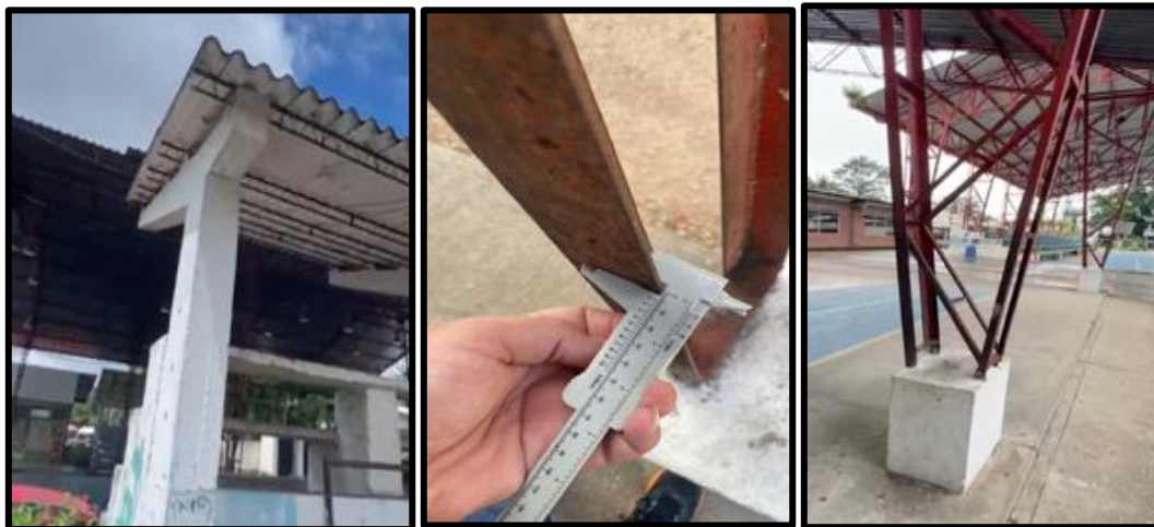
Ilustración 6: Estructura metálica polideportivo auxiliar.
