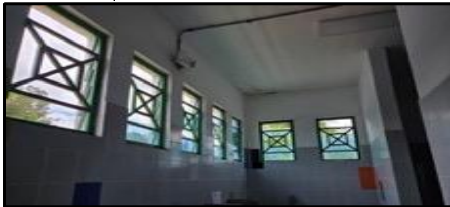
Ilustración 38: Ventanas objeto de instalación de angeo.
