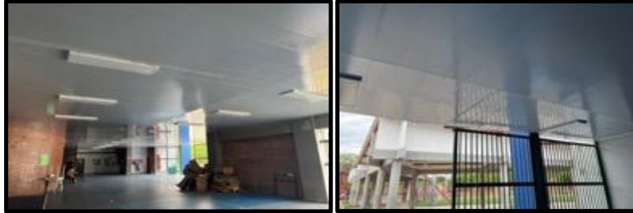
Ilustración 1: Cielo raso en ingreso a instalaciones.
