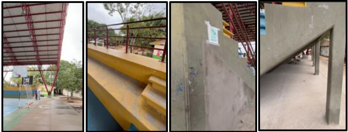
Ilustración 21: Elementos objeto de hidro lavado
