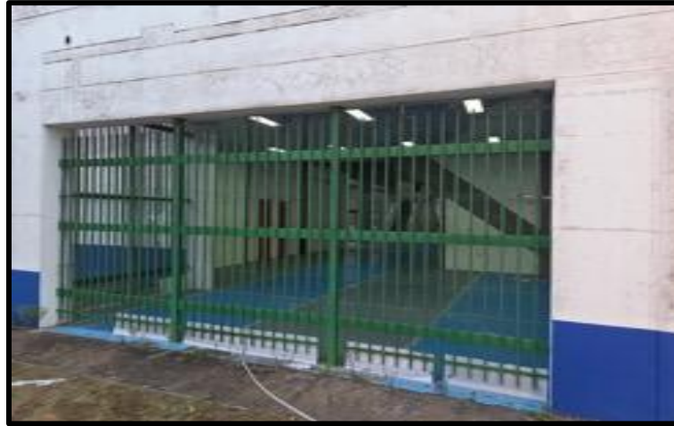
Ilustración 37: Rejas en fachada del complejo deportivo INDER.
