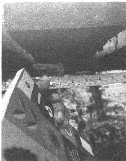
Foto 11 — Medición expedita de la sección de un elemento angular de apoyo del tablero
