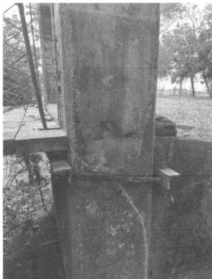
Foto 9 — Superficie del pórtico de concreto en la zona de apoyo del cable principal
