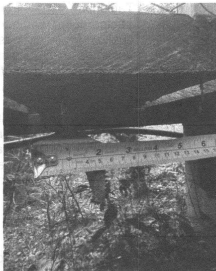
Foto 12 — Medición expedita del ancho de un tablón de madera del tablero existente
