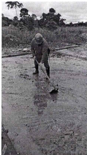
Personal operativo laborando en condiciones de lodazal: imposibilidad de tránsito y operación en temporada de lluvias.
