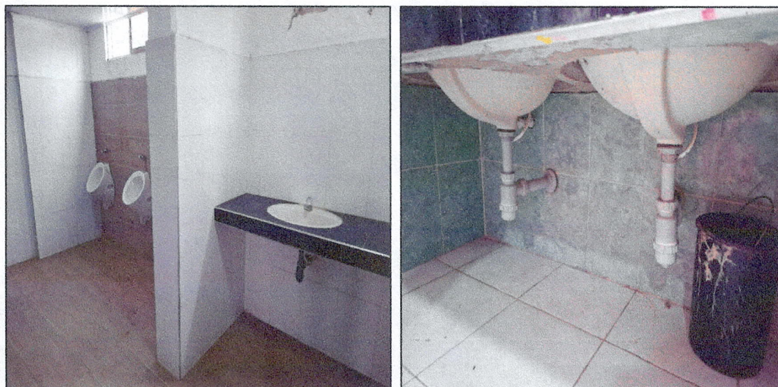
Ilustración 4. Baños hombres y mujeres del Centro de Convivencia del municipio de Arauquita.
