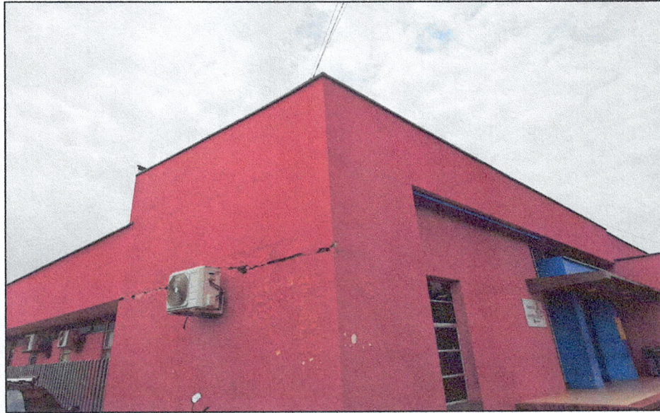
Ilustración 1. Fachada principal del Centro de Convivencia del municipio de Arauquita. Grietas, presencia de humedad y deterioro de pintura.
