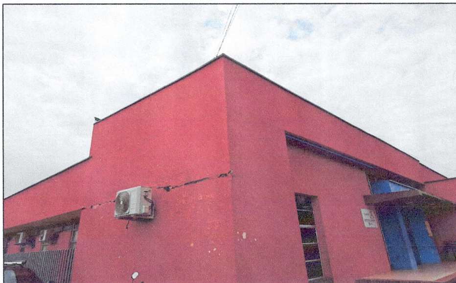
Ilustración 1. Fachada principal del Centro de Convivencia del municipio de Arauquita. Grietas, presencia de humedad y deterioro de pintura.
